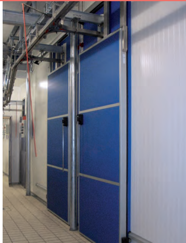
Porte frigorifere scorrevoli con e senza passaggio guidovia Sliding refrigeration door with and without rail passage
